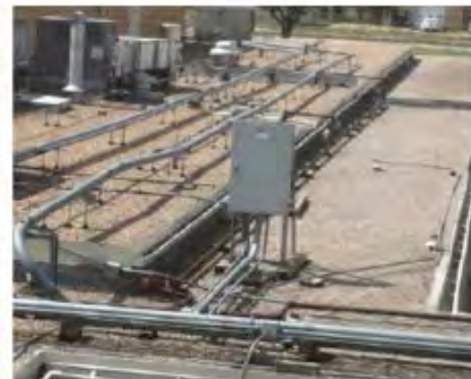
Existing Conduit on Roof
